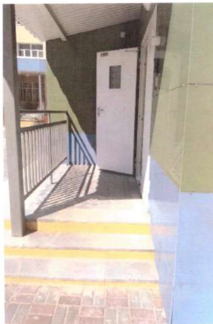
Фото №27 «Эвакуационный выход»
