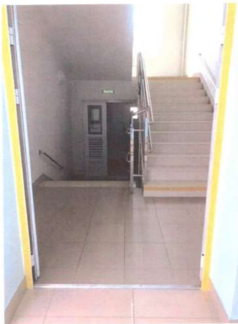
Фото №22 «Лестничная площадка»
