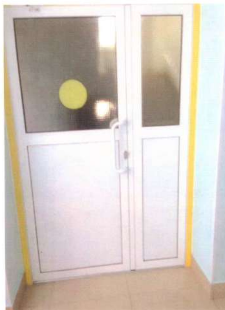
Фото № 21 «Дверь на лестничную площадку»
