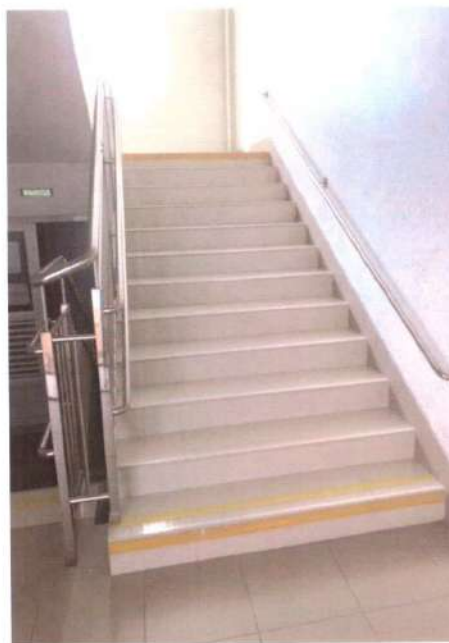
Фото №23 «Лестничная площадка»
