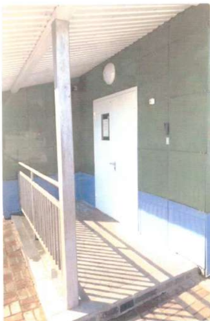
Фото №31 «Эвакуационный выход»
