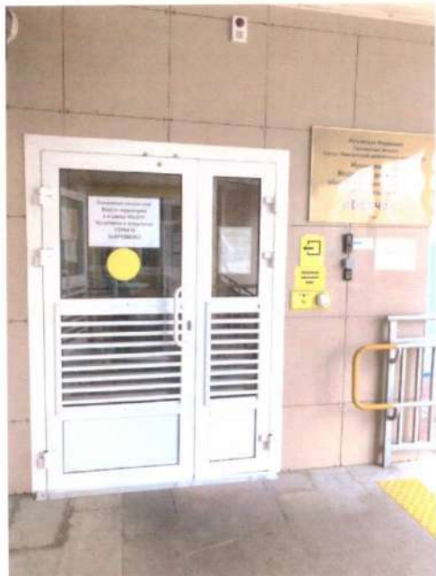
Фото №14 «Входная дверь»
