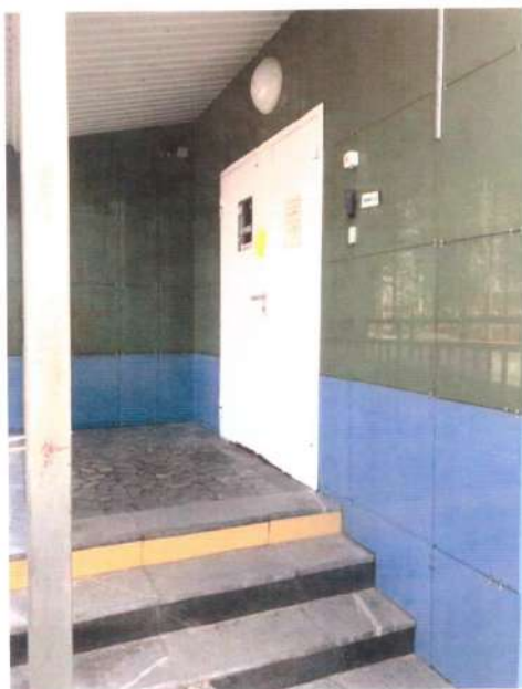
Фото №32 «Эвакуационный выход»
