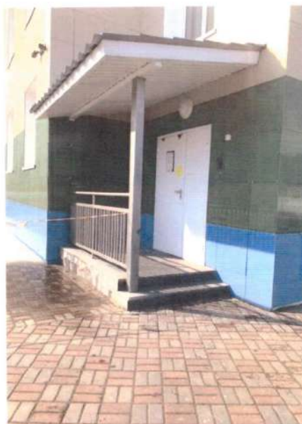
Фото №29 «Эвакуационный выход»
