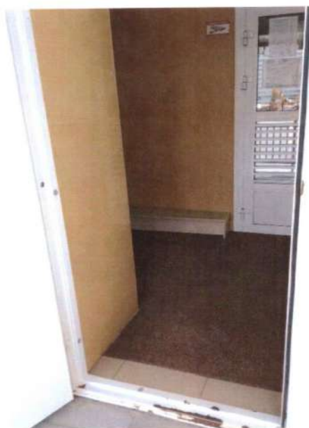
Фото №28 «Эвакуационный выход»
