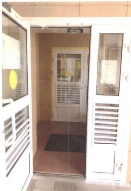
Фото №15 «Входная дверь»
