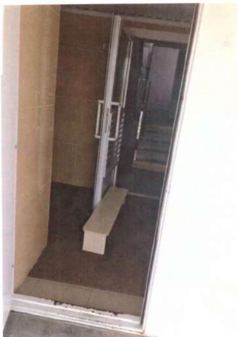
Фото №30 «Эвакуационный выход»
