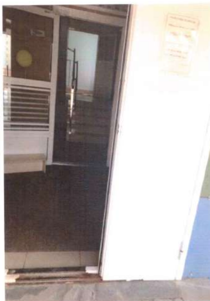
Фото №33 «Эвакуационный выход»
