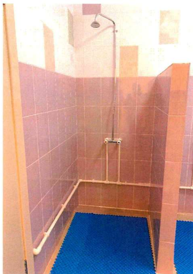
Фото № 48 «Вход в душевые кабины»
