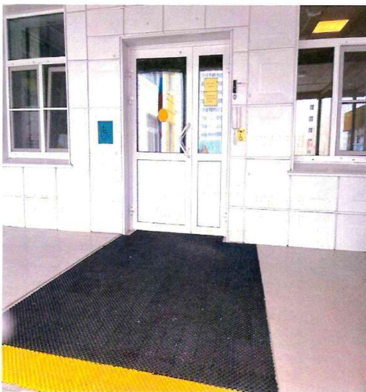
Фото №11 «Входная площадка»
