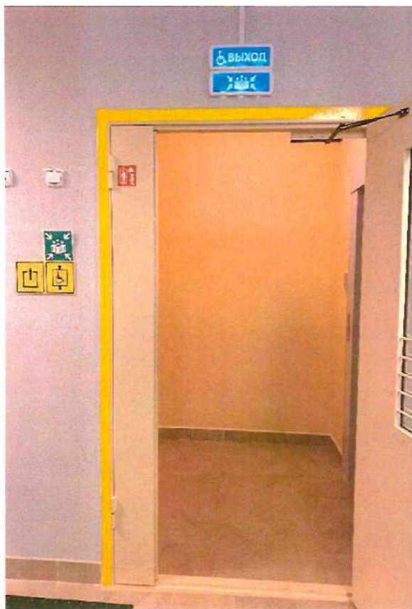
Фото №25 «Вход в лифт»
