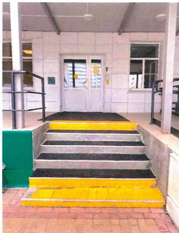
Фото №8 «Лестница наружная»
