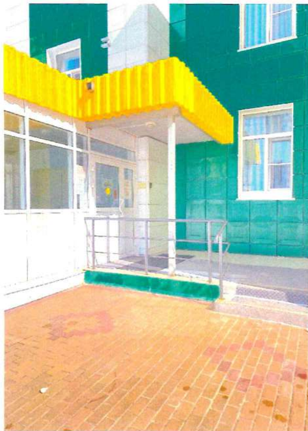
Фото №28 «Эвакуационный выход»
