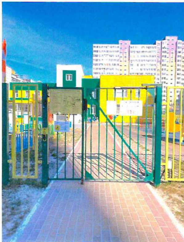
Фото №1 «Вход на территорию»
