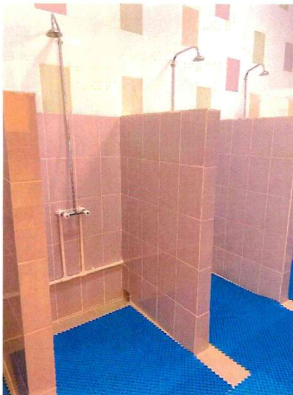
Фото № 49 «Душевые кабины в бассейне»
